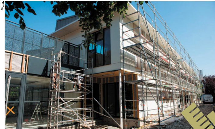
Travaux au centre de loisirs des Bons-Raisins.
