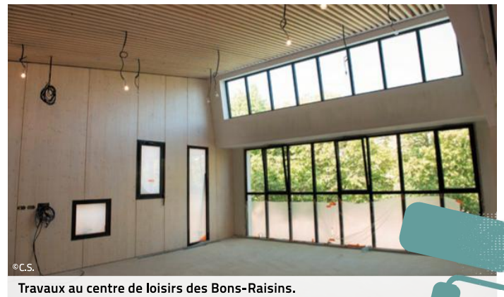
Travaux au centre de loisirs des Bons-Raisins.
